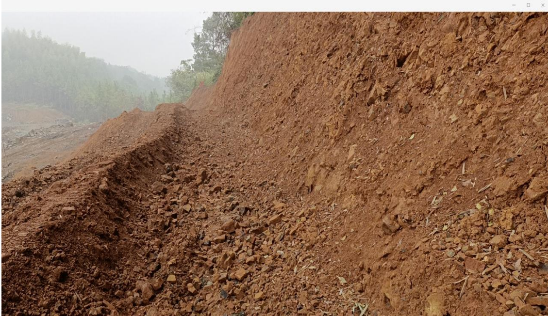
图 2-7 矿区南部截水沟
